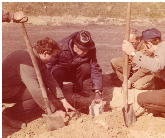
Pierwsze prace ziemne
